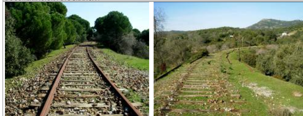
Vistas de la vía férrea en distintos tramos
